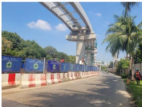
การดำเนินการขยับแนวเบริเออร์กั้นขอบเขตพื้นที่ก่อสร้างชิดเสาทางวิ่งยกระดับเพื่อให้สะดวกต่อการสัญจร
