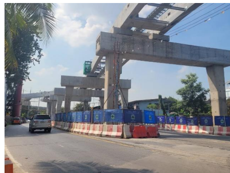
การดำเนินการขยับแนวเบริเออร์กั้นขอบเขตพื้นที่ก่อสร้างชิดเสาทางวิ่งยกระดับเพื่อให้สะดวกต่อการสัญจร
